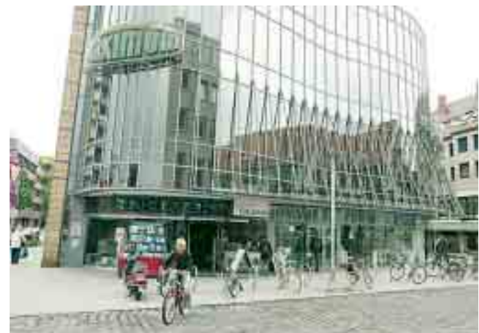
Das Maximum wird nach der Schneider-Pleite noch immer zwangsverwaltet. Die Buchhandlung Edelmann belegt jetzt nur noch das Erdgeschoss.
